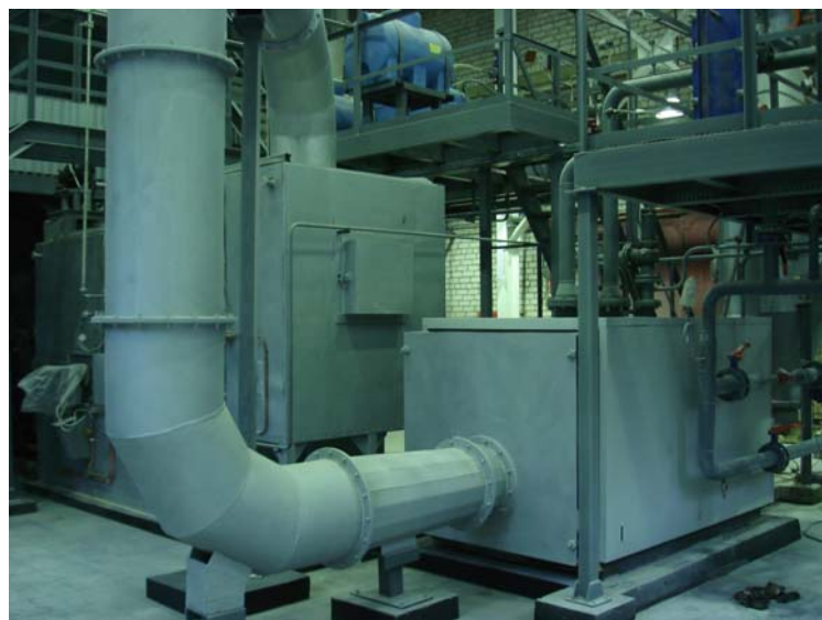
КТО-150 (на заднем плане) и котел-утилизатор
