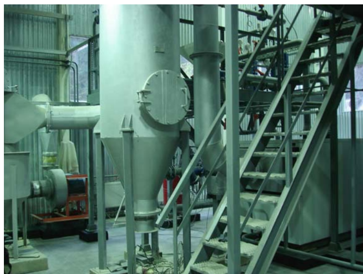
Общий вид. Лестница на второй уровень
